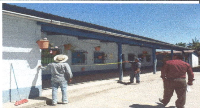
Foto1: Sustitucion de lamina Troquelada.
