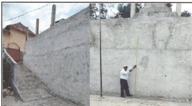
Foto 3: Pintura en muro interior de el establecimieto.
