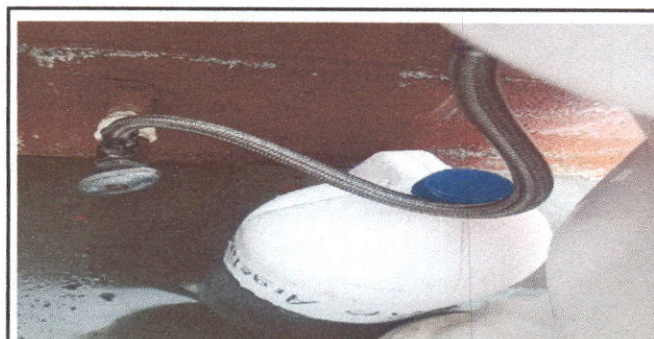
Foto 6: Sustitución de accesorios de inodoro.
