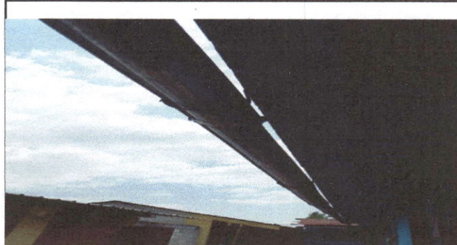
Foto 2: Sustitución de canal de pvc
