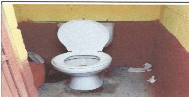
Foto 5: Sustitución de inodoro.
